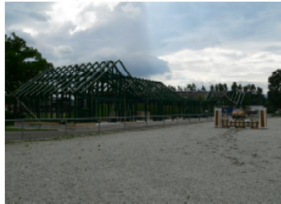
Der erhöhte Mittelteil für den VIP-Bereich wurde nach der Fertigstellung des Fußbodens aufgesetzt.
