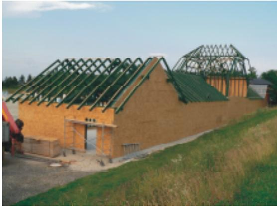
Die gesamte Dachfläche wurde mit in Kontrastfarbe gestrichenen Nut-Feder-Brettern verschalt und für die Eindeckung mit Dachziegeln vorbereitet.
